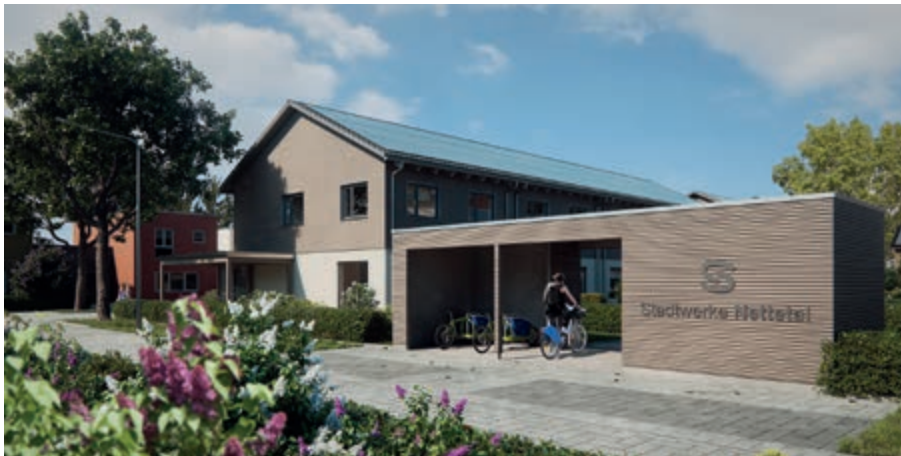
Zwei Energiestationen nehmen die Technik der Stadtwerke Nettetal auf, vom Stromspeicher bis hin zum Lastenradverleih
